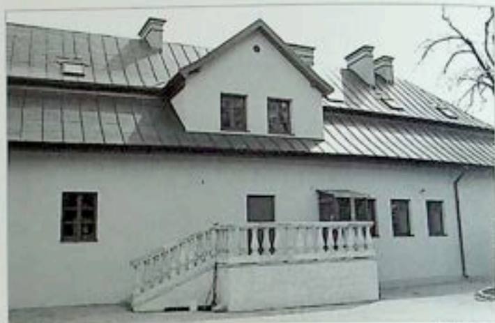
...i po remoncie
